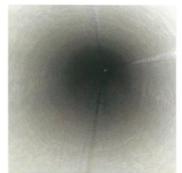
施工後更生管内
